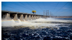
Жигулевская ГЭС, Самарская область.
