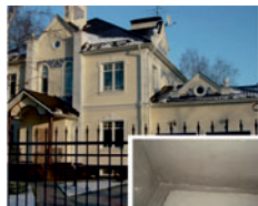
Подвальное помещение коттеджа в пос. «Спутник», Московская область.
